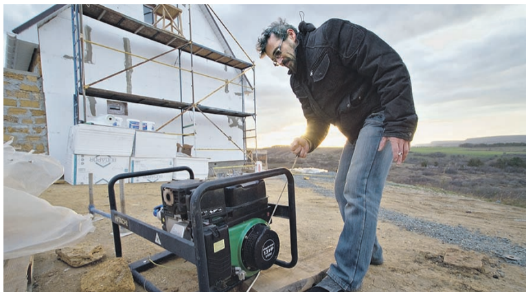
← Житель села Клиновка Симферопольского района запускает генератор около своего строящегося дома
