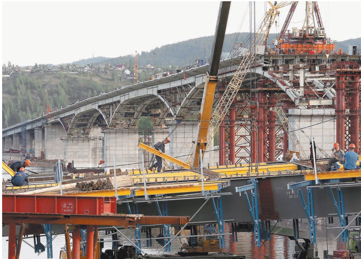
Енисей - самая полноводная река Евразии - у мостостроителей считается крепким орешком. Тем не менее в Красноярске полным ходом идёт строительство уже четвёртого моста через Енисей. Длинной в 1160 м, в шесть полос, со сложнейшими развязками, он должен быть закончен нынешней осенью. Фото Рейтер
